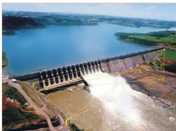
Figura 1 - Rede externa de pontos para o monitoramento
