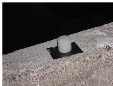
Figura 4 – Alvos na crista da barragem
